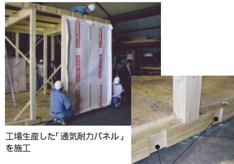
工場生産した「通気耐力パネル」を施工
