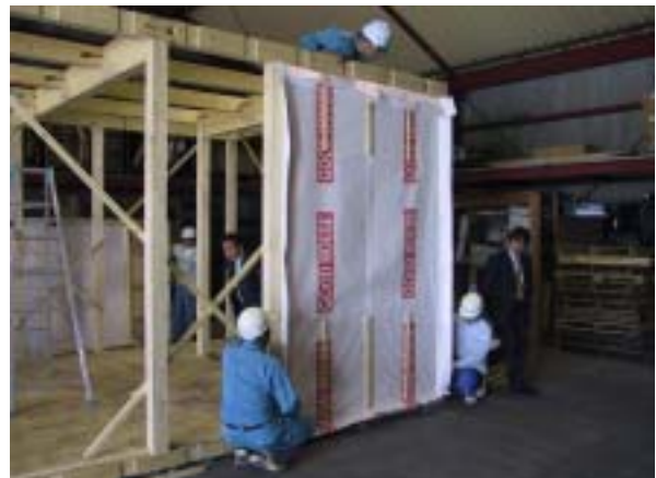
工場生産した「通気耐力壁パネル」を施工
