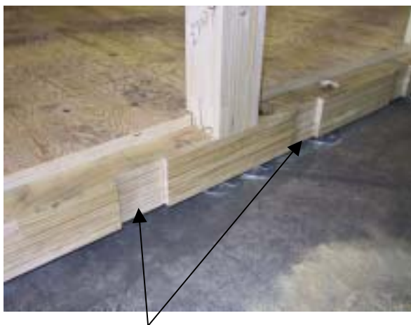
工場プレカットによる横架材の通気欠き込み
