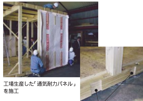
工場プレカットによる横架材の通気欠き込み
